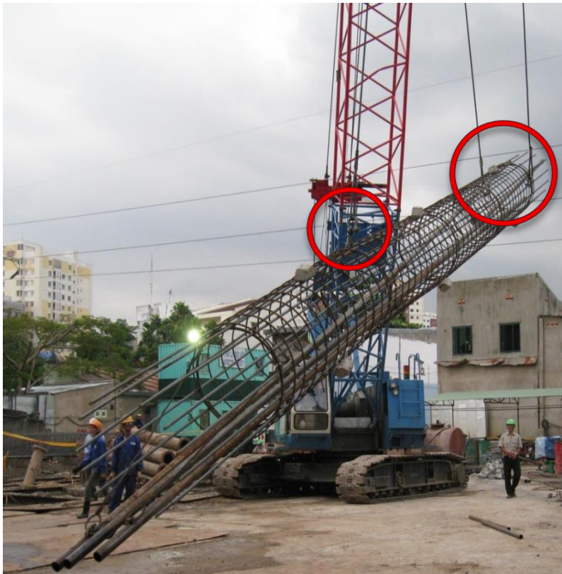
Cầu lắp lồng thép vào vị trí lỗ khoan (lưu ý vị trí cầu)
