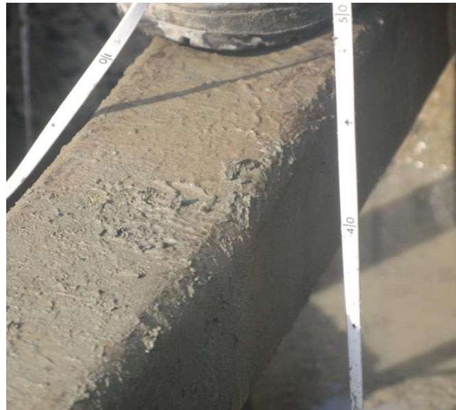
Kiểm tra cao độ bê tông
