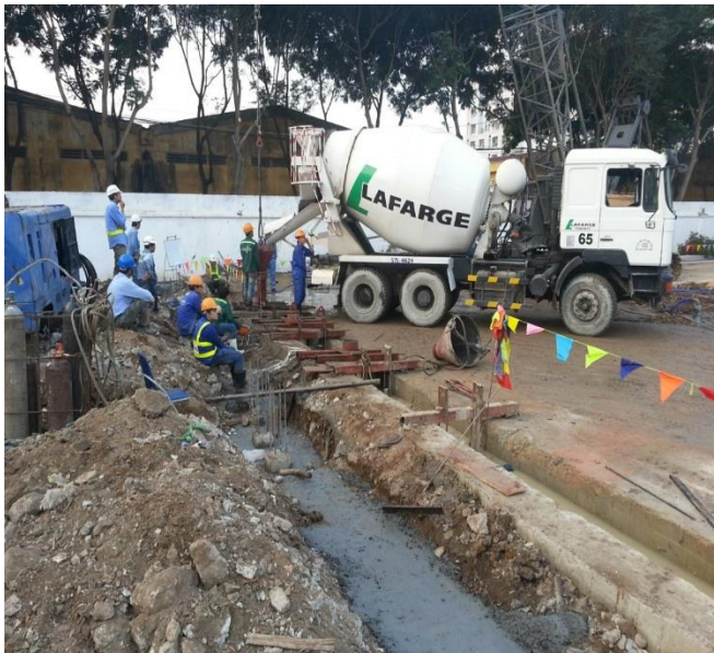
Đổ bê tông
