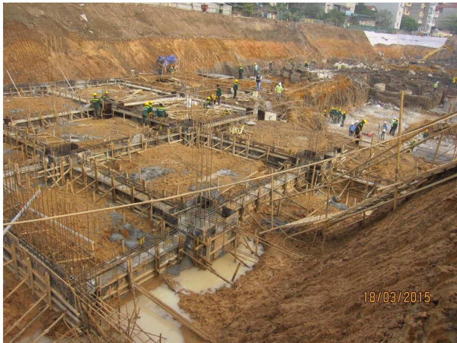
Đào mở vách taluy
