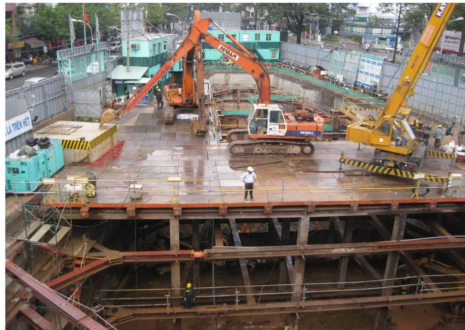
Đào mở dùng tường chắn
