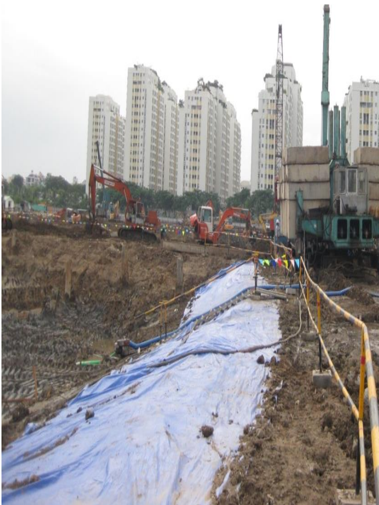
Thiết bị nặng nằm sát mái dốc
