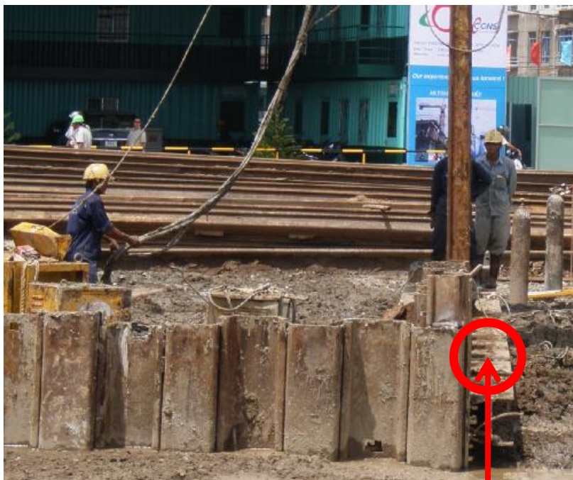
Hệ thống dẫn hướng khi ép cừ
