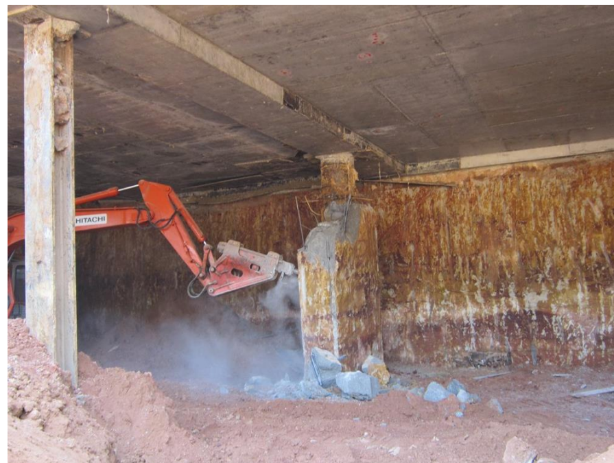
Đục bê tông quanh Kingpost
