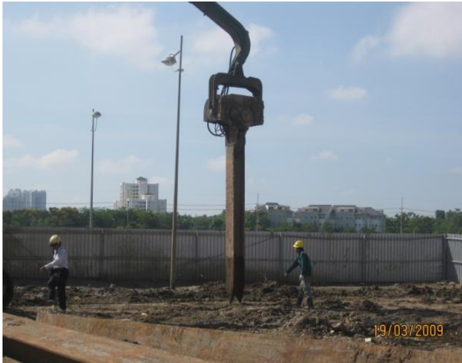
Ép cọc bằng máy
