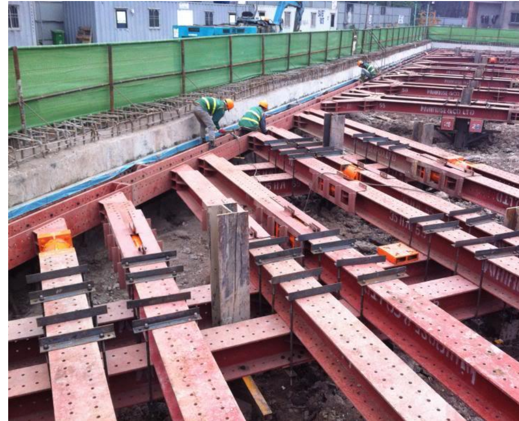
Lắp đặt cùm
