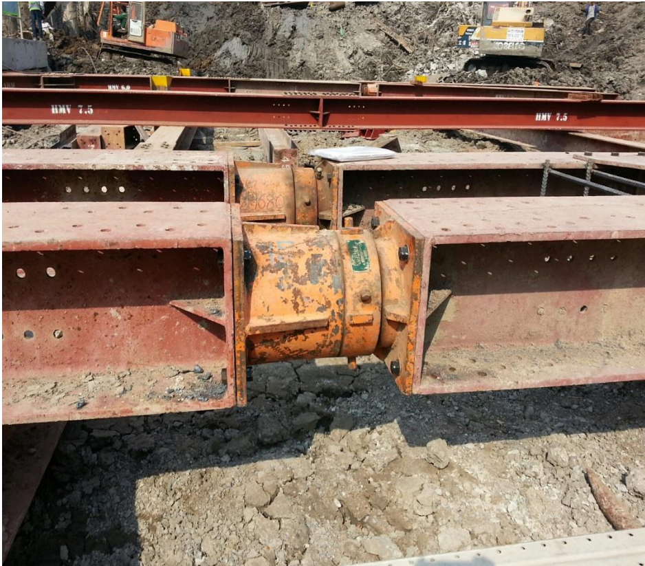
Lắp đặt kích
