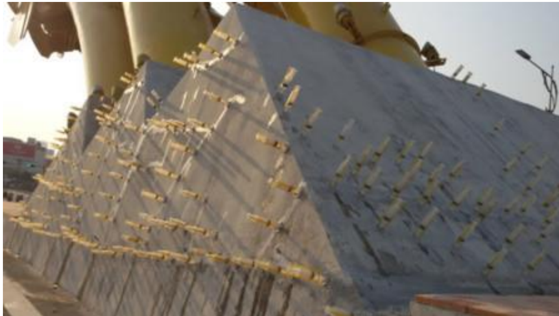
Bề mặt bê tông chứa đầy xilanh
