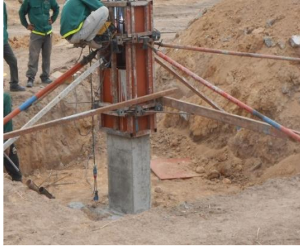
LẮP ĐẶT BU LÔNG NEO
