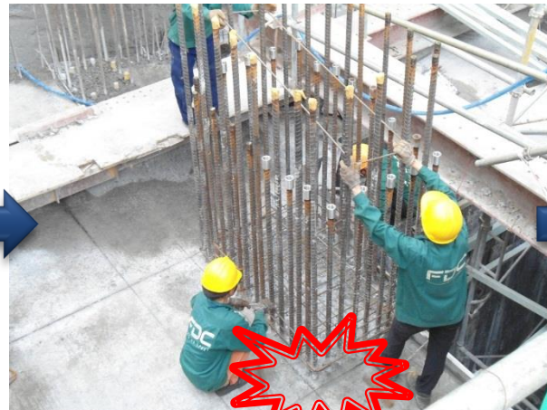
Búng mực da bê tông
