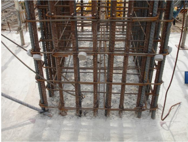
Vệ sinh thép cột, đục nhám đầu cột sau khi đổ bê tông
