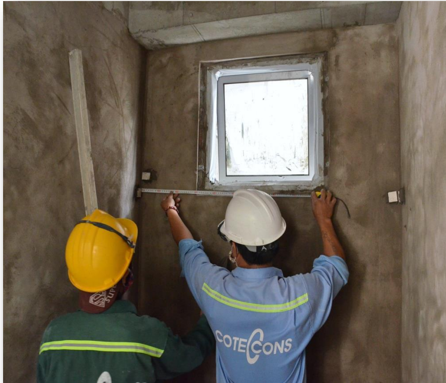
Ghém tường – mục đích lấy lại kích thước tuyệt đối theo thiết kế
