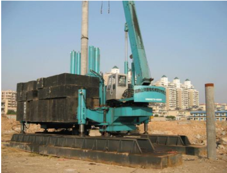
Ro cốt ép cọc
