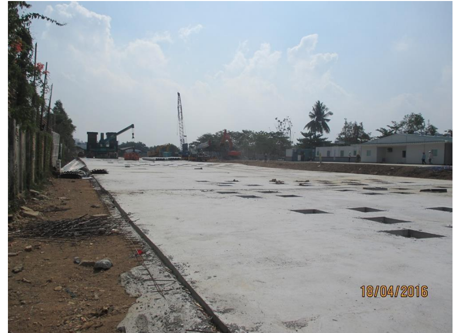
Thi công sàn platform phục vụ ép cọc
