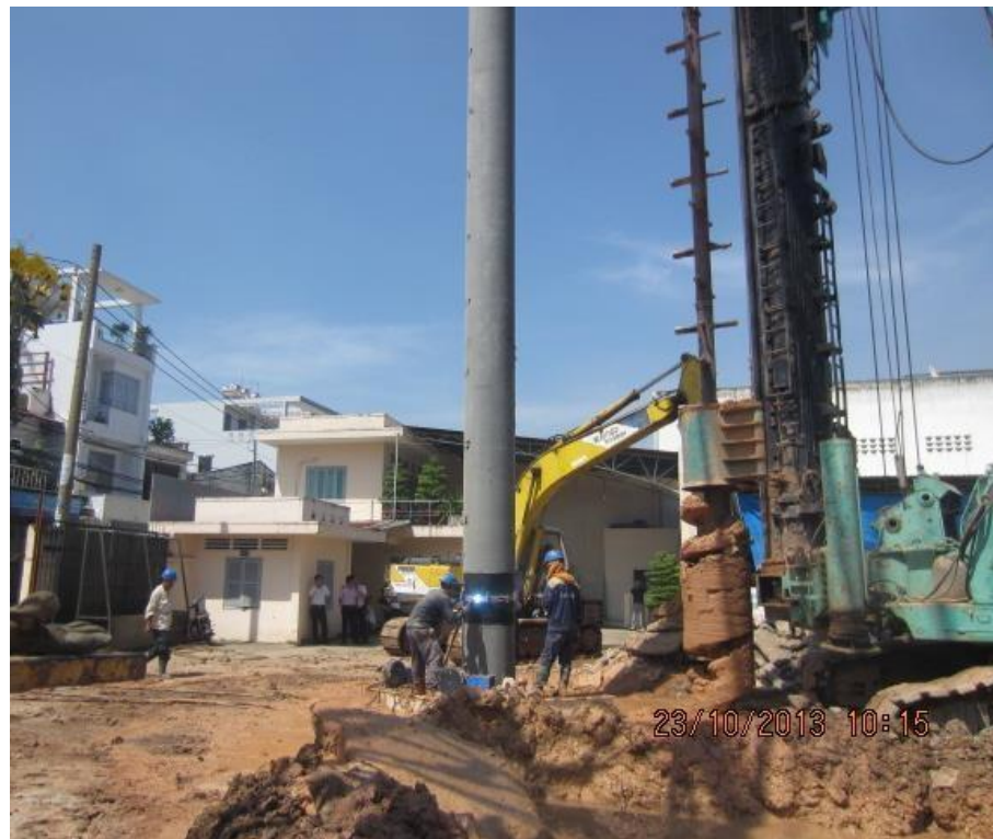
Khoan dẫn tạo lỗ trong quá trình ép cọc
