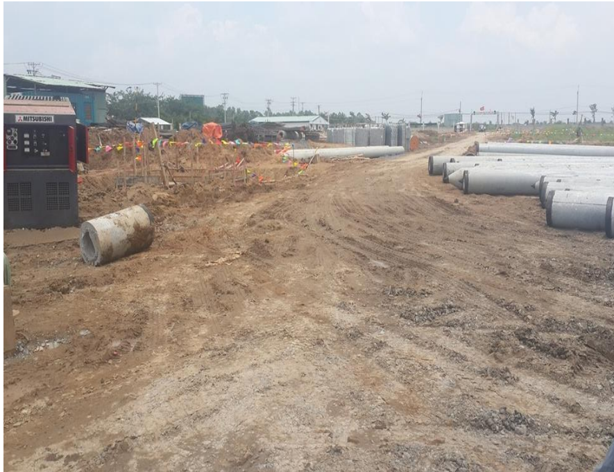
Làm đường tạm phục vụ cấp cọc
