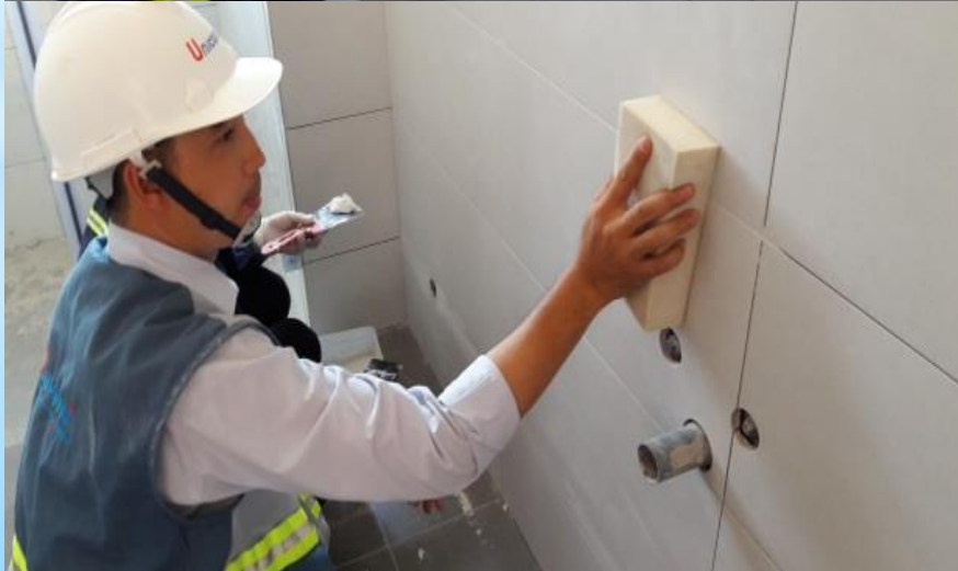
ĐÚNG: Chà ron bằng dụng cụ chà ron
