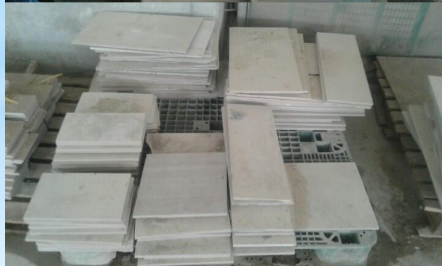
ĐÚNG: Tận dụng được các KT gạch khác nhau .Tiết kiệm hao hụt
