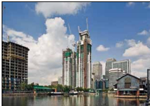
Hình 6.1 – Thi công nhà cao tầng
