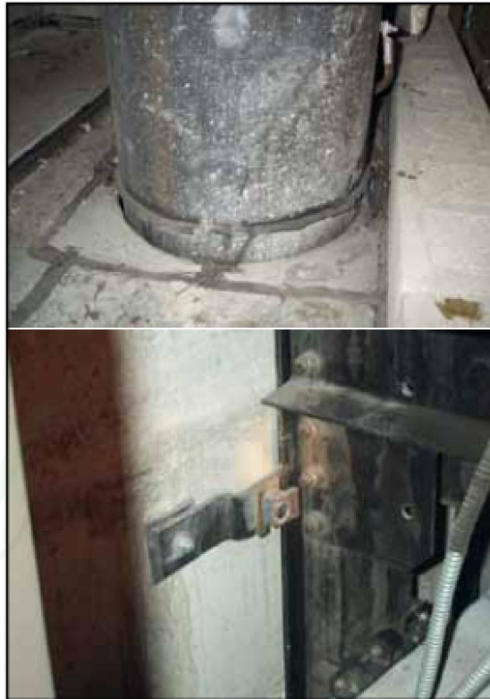
Hình 11.2 - Phá hoại bám dính giữa keo và sàn (trên) và vết xước trong ray dẫn hướng thang máy (dưới) do chuyển dịch xuống của kết cấu công trình nhà (90 mm) so với các phần tử phi kết cấu (Bast và cộng sự 2003) [25] .
