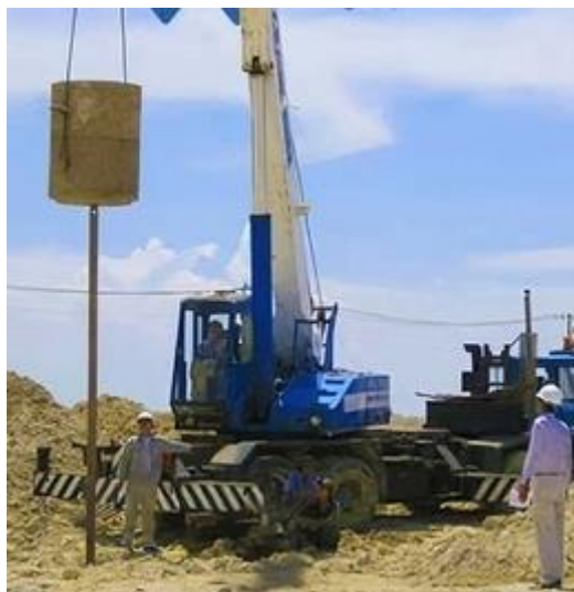
Hình 4. Thử tải cọc và thiết bị phân tích thí nghiệm thử động biến dạng lớn PDA [11]
